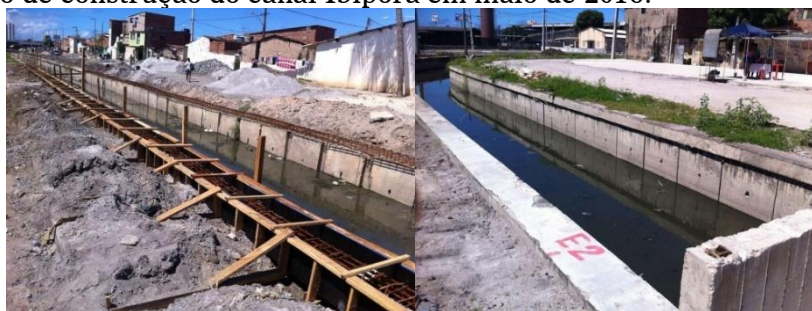
Figura 5: Processo de construção do canal Ibiporã em maio de 2016.
