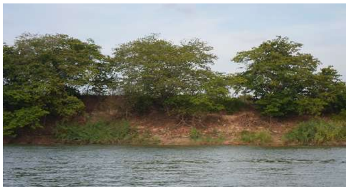
Figura 3 – Degradação do Rio Tocantins vista do Bairro Santa Inês
